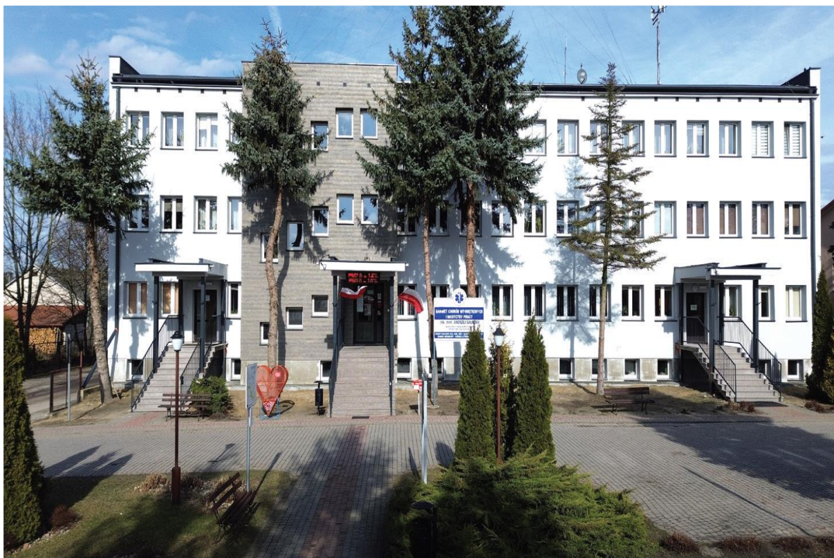
Budynek Urzędu Gminy w Serokomli
