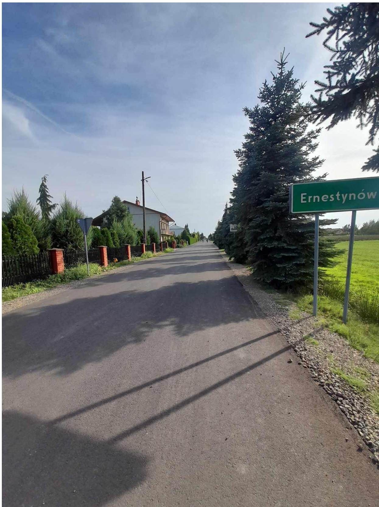
Droga gminna Nr 102723L w miejscowości Ernestynów
